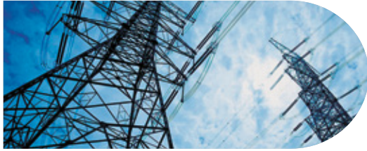
ПЕРЕДАЧА И РАСПРЕДЕЛЕНИЕ ЭЛЕКТРОЭНЕРГИИ
